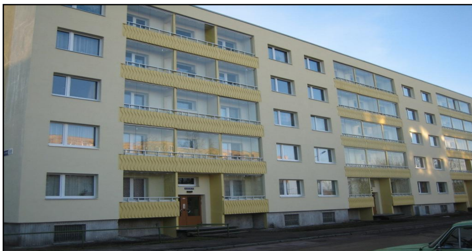
Рис. 14. Здание после ремонта
