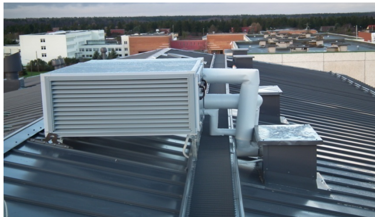
Рис. 41. Вид вентиляционной системы на крыше дома
