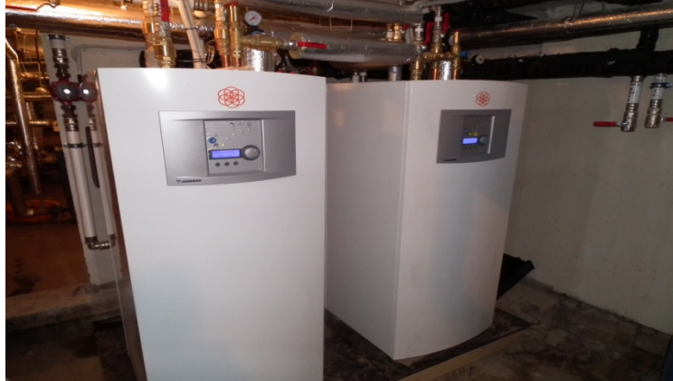
Рис. 40. Теплообменники вентиляционной системы
