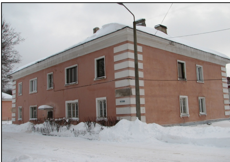
Рис.24. Общий вид объекта
